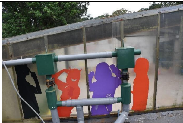
雨水回收系統-沖廁與澆灌
