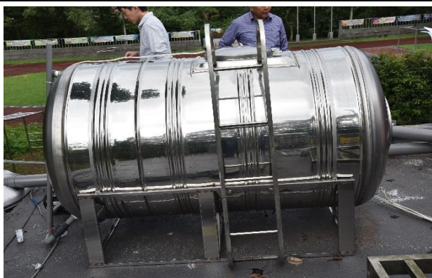
雨水回收系統-沖廁與澆灌
